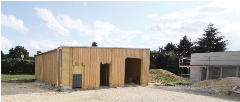
Das (fast) fertige Nebengebäude
